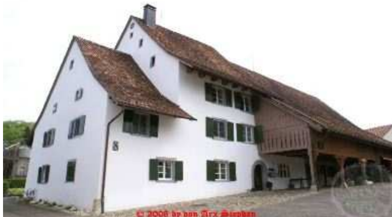
Kernbau des Arxhofes
