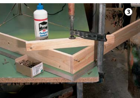
Winkelgerecht und seitenkantenbündig ausgerichtet werden die beiden Rahmenteile zum Verschrauben auf die Unterlage gespannt. Ein übergelegtes Kantholz mit angesetzter Schraubzwinge fixiert die Teile sicher in dieser Position.
