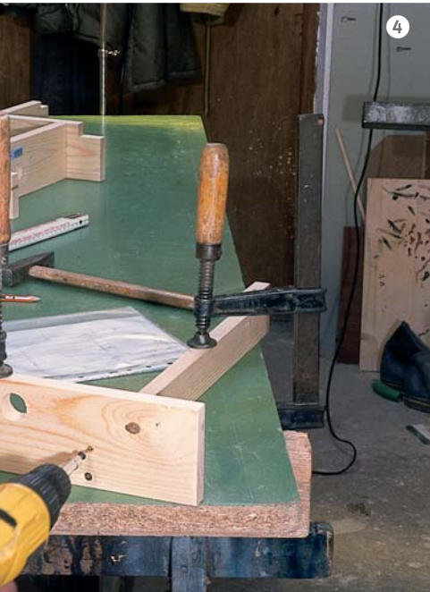
Wie in Abb. 3 dargestellt werden hier zwei Innenstreben miteinander verschraubt. Ein Teil der schon verbundenen Innenstreben liegt im Hintergrund. Teils sind schon die Bohrlöcher zur späteren Kabeldurchführung angebracht.
